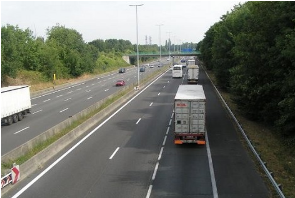
Autoroute A1 à proximité de Senlis (Source : DDT/60SAUE)
