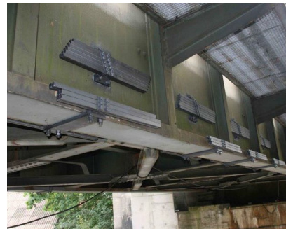
Absorbeur sur platelage
