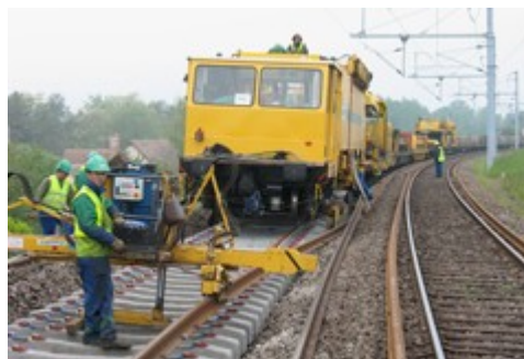
Longs Rails soudés sur traverses béton
