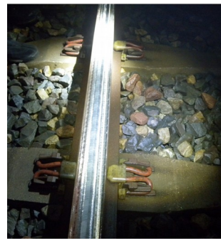
Rail après meulage
